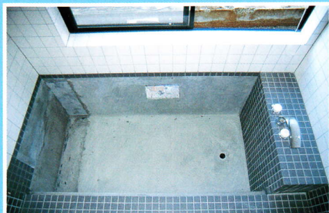
クリーンウッド浴槽設置前の仕上り
